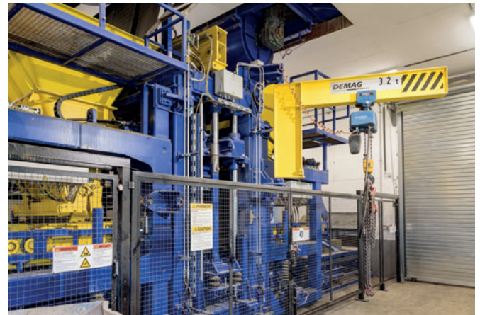
Les principaux composants de la machine XL 9.1 : l'élément de compactage est positionné entre les deux éléments de chargement de béton de corps et de béton de parement.
