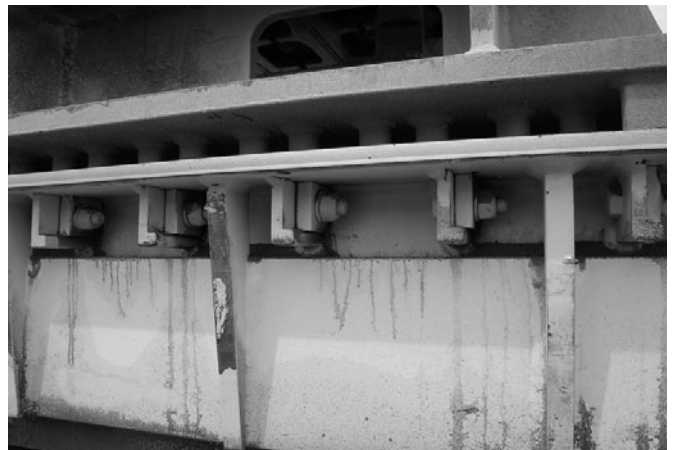
Figure 3 : Boulonnage horizontal
