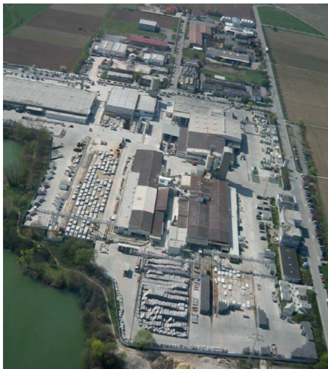
Le centre de création de valeur de l'entreprise traditionnelle souabe de fabrication de pièces de béton se trouve sur le site de Tübingen Hirschau
