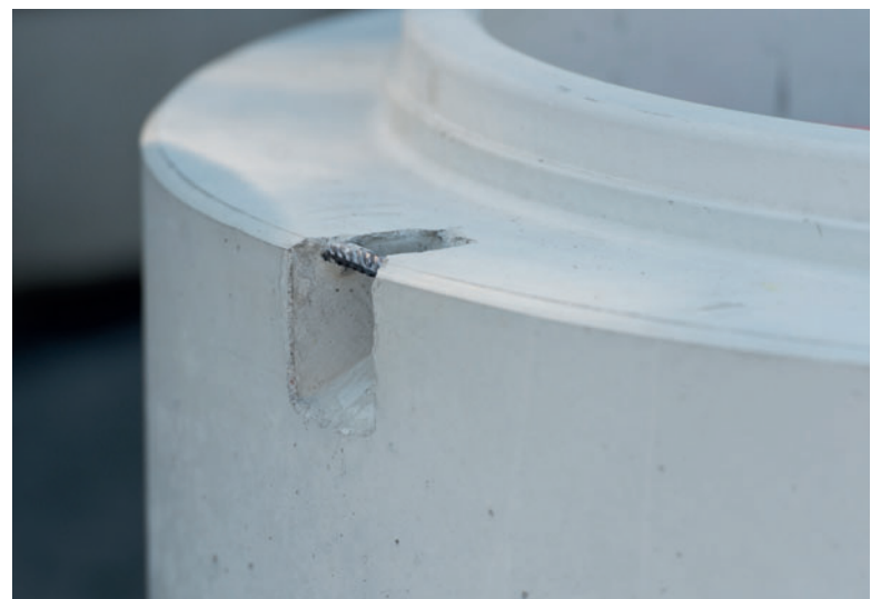
Utilisées sur chantier des aides à la pose, moulées dans le béton, contribuent à la sécurité de la manutention
