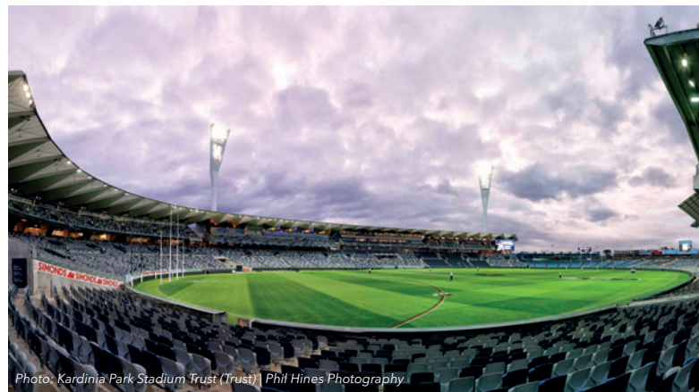
Para el estadio Simonds de Geelong (Australia), Westkon Precast fabrica más de 8500 m 2 de placas alveolares pretensadas y 1250 m 2 de placas para asientos.
