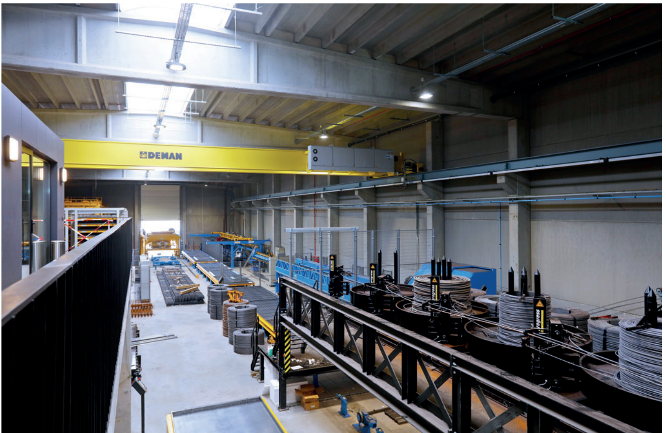
Das Umlaufsystem wurde auf engstem Raum installiert und automatisiert wichtige Arbeitsschritte.
