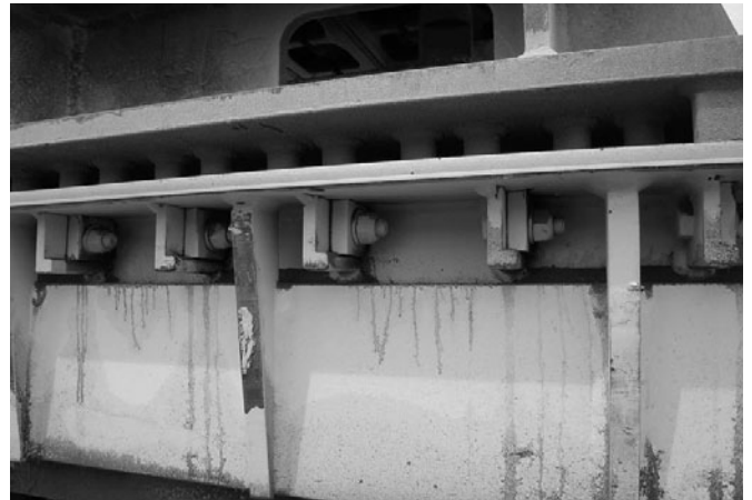
Bild 3: Horizontale Verschraubung
