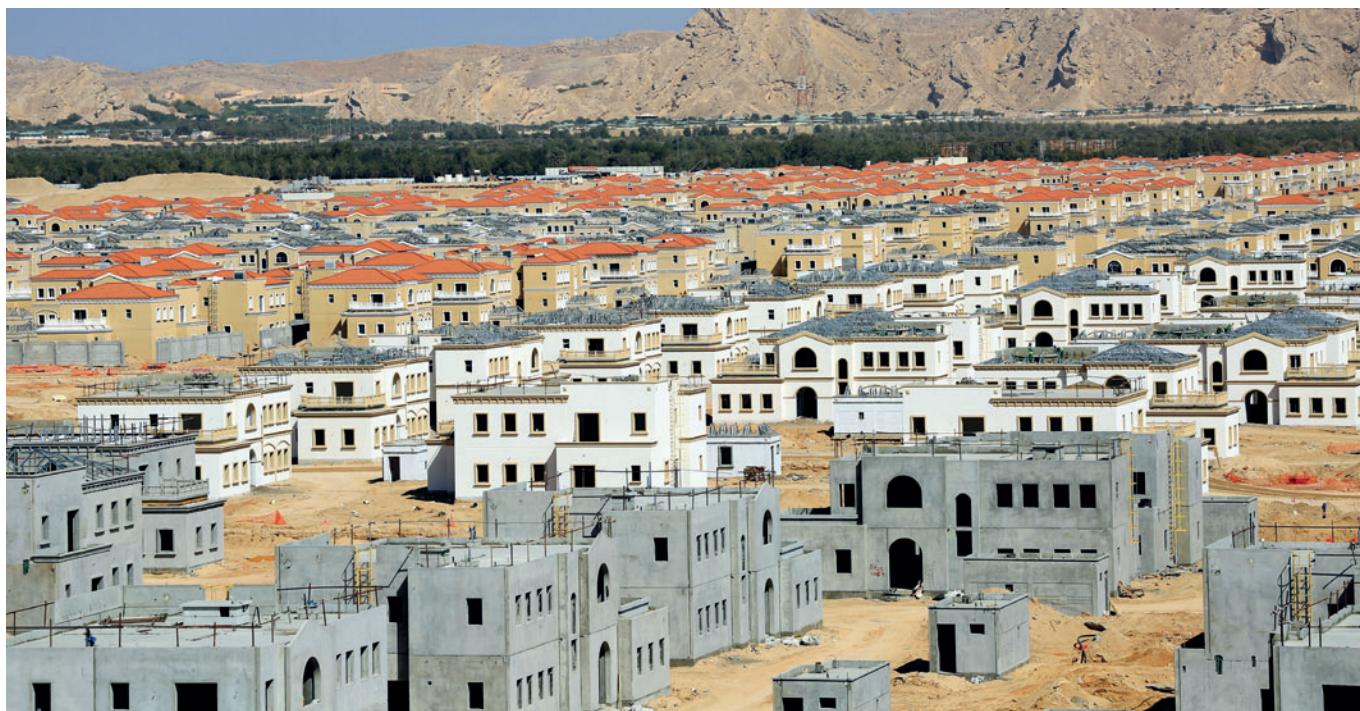
Пример виллы «хай-тек» из сборного железобетона, который наглядно демонстрирует преимущества сборного ж/б строительства: скорость, качество, эффективность, универсальность и долговечность
