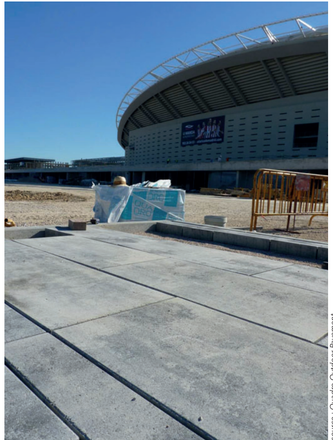
Pose des pavés en béton mis en œuvre pour l'extérieur - photo
