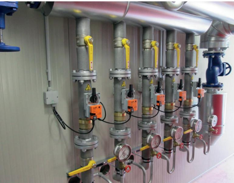
Un ensemble de 6 conduites d'eau chaude permet d'alimenter en eau chaude à 95 °C un total de 6 bancs de précontrainte. Chaque conduite est équipée d'une vanne automatique avec actionneur (de couleur orange). Une conduite de retour principale ramène l'eau depuis les six bancs de précontrainte vers la chaudière, où elle est de nouveau réchauffée.
