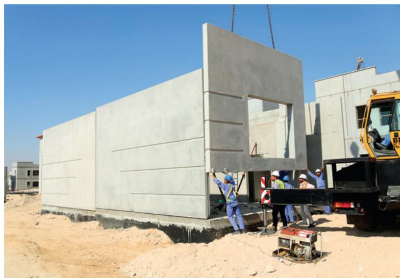
Exemple de dalles de béton préfabriquées de la société Hi-Tech utilisées dans le cadre d'un système permettant la construction rapide et efficace de maisons d'habitation, de bâtiments commerciaux et d'ouvrages de moyenne hauteur.
