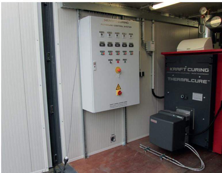
*Le système de commande de durcissement du béton automatique régule individuellement la température des 6 bancs de précontrainte avec l'aide de capteurs de température vissés dans les bancs. Un système de commande de durcissement du béton économique et efficace.*
