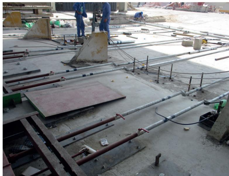
*Installation au niveau du sol des conduites départ et retour d'eau chaude du système ThermalCure et raccordements aux bancs de précontrainte.*
