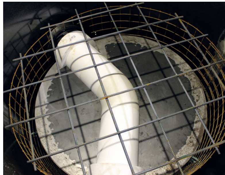
y armadura de la base de este.
