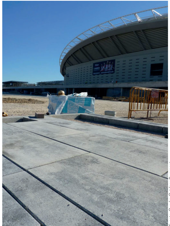
Colocación de los bloques de hormigón empleados en los espacios exteriores - Fotografía
