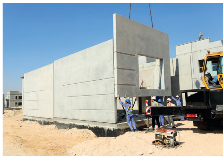
Un ejemplo de placas de hormigón prefabricadas de Hi-Tech montadas en un sistema para la construcción eficiente y rápida de viviendas, edificios comerciales y estructuras de mediana altura.
