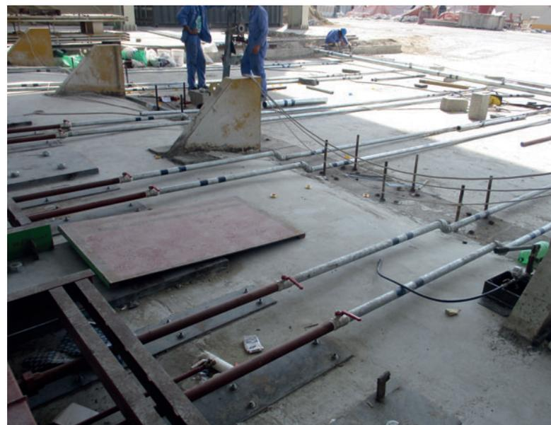
Bodenebene Installation der Warmwasservor- und -rücklaufleitungen von ThermalCure und Anschlüsse an die Spannbetten
