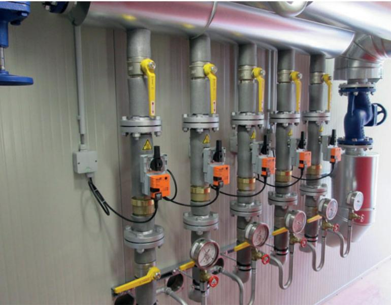
Insgesamt 6 Warmwasserleitungen versorgen insgesamt 6 Spannbetten mit 95°C heißem Wasser. Jede Leitung ist mit einem automatischen Ventil mit (orangefarbenem) Aktuator ausgestattet. Eine Hauptrücklaufleitung leitet das Wasser aller sechs Spannbetten zurück zum Kessel, wo es erneut aufgewärmt wird.
