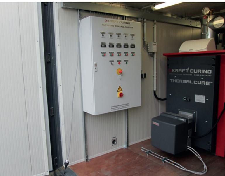
Das automatische Betonaushärtungssteuerungssystem regelt die Temperatur von 6 Spannbetten individuell mit Hilfe von in den Betten verschraubten Temperatursensoren. Ein wirtschaftliches und effektives Betonaushärtungssteuerungssystem.
