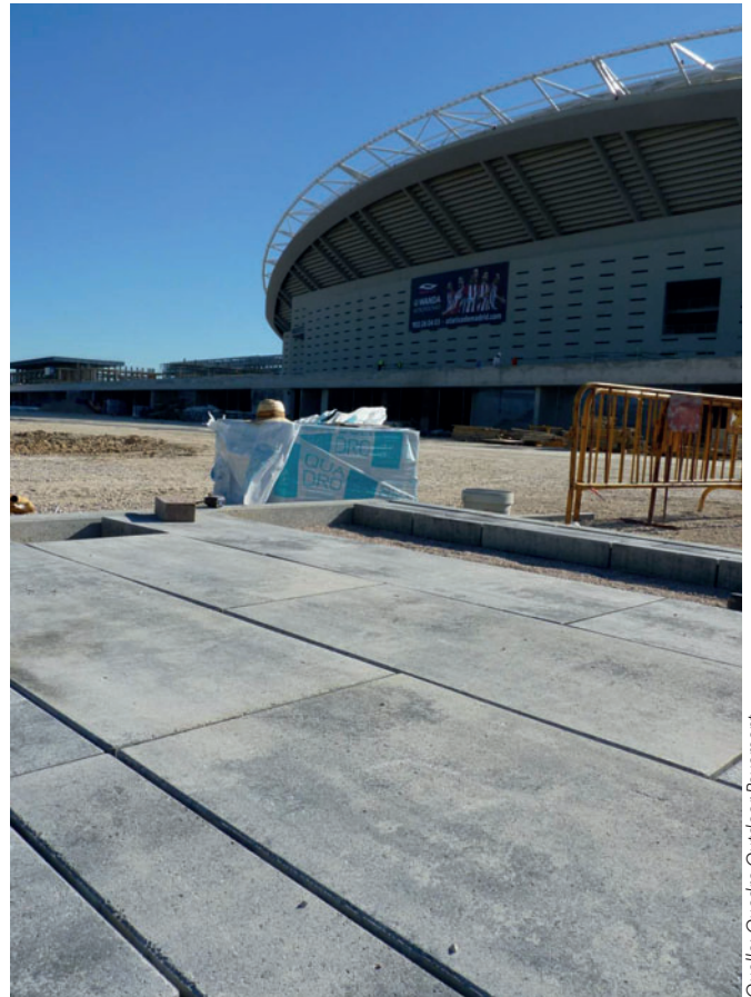
Verlegung der im Außenbereich verwendeten Betonsteine - Fotografie
