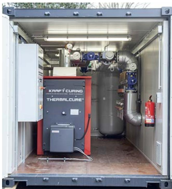
Для текущего проекта туннеля Альбфорланд компания Kraft поставила систему ускоренной выдержки Thermalcure®, центральный компонент которой (водяной котел) расположен в теплоизолированном, вентилируемом и обогреваемом контейнере
