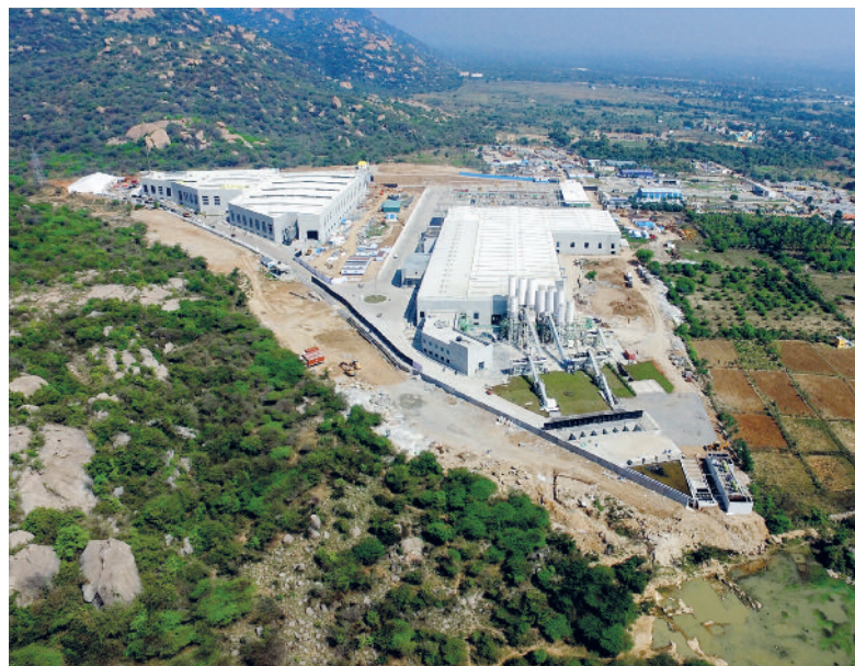
W parku przemysłowym „KEF Infra One Park” w pobliżu Bangalory wytwarzana jest większość elementów potrzebnych do wznoszenia budynków mieszkalnych i przemysłowych oraz szpitali i szkół.
