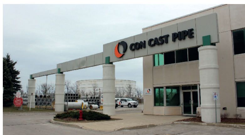
Con Cast Pipe w Oakville.
