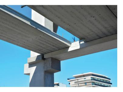
Per la Ergon il solaio alveolare precompresso è "uno degli sviluppi più importanti nel campo della prefabbricazione in calcestruzzo". Sarebbero molto richiesti nel settore edile per le loro numerose caratteristiche positive.
