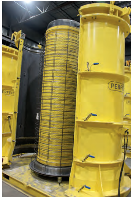
Fertig präpariert mit Liner und Bewehrungskorb
