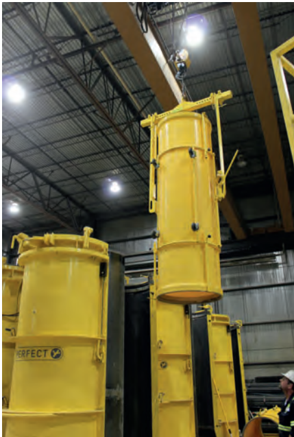
Mittels Kran wird der umgeformte Liner (mit Muffen) zur Schalungsform transportiert und über den schrumpfbaren Formenkern abgelassen.
