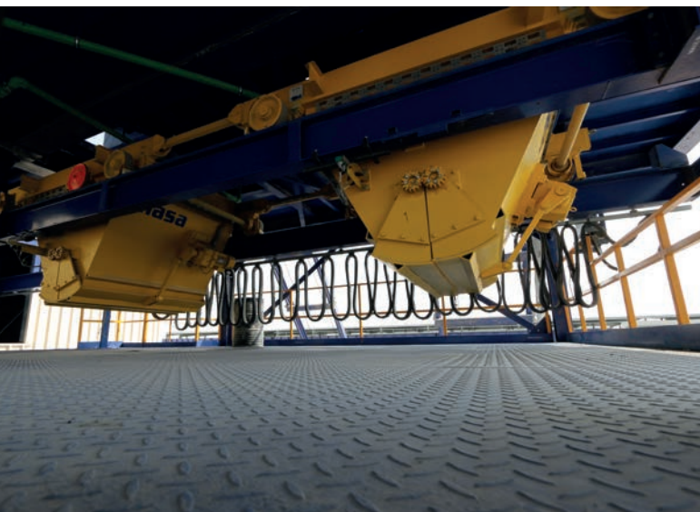
已搅拌的混凝土将通过双料斗输送机运输到砌块成型机
