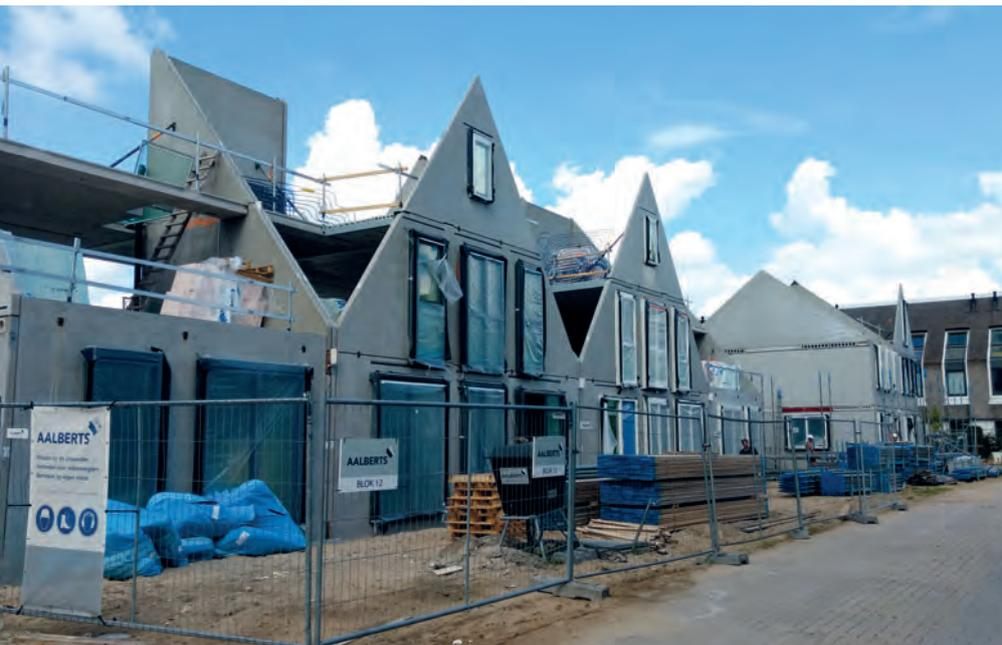
*Entre tanto, la construcción con elementos prefabricados de hormigón también ha ganado gran popularidad en la construcción de viviendas en el sector privado. Un concepto de montaje especial permite a los clientes de Geelen Beton realizar sus objetos en muy poco tiempo.*
