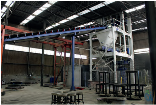
Подача бетона на радиальный пресс RP 1630
