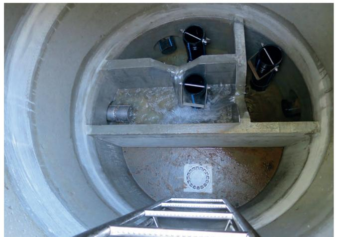
Вид изнутри: изготовленный компанией Wyss AG каптаж диаметром DN1500 с несколькими приточными и сточными патрубками и 4 камерами, установленный в общине Вицнау на Фирвальдштетском озере
