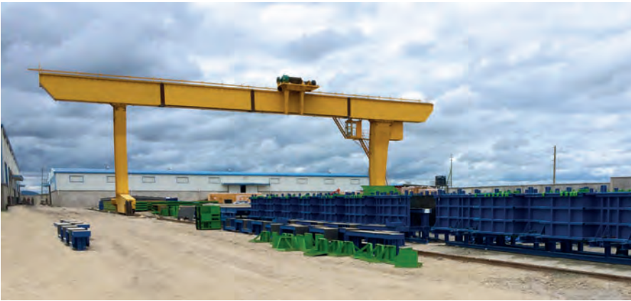
Con un totale di sei casseri, lunghi 18 m ciascuno, si producono i pilastri per l'edilizia commerciale.
