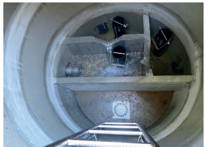
Interno di un tubo per pozzo di raccolta in calcestruzzo DN1500 prodotto dalla Wyss AG con entrate multiple e 4 camere presso la presa di captazione da sorgente del comune di Vitznau sul Lago dei Quattro Cantoni.
