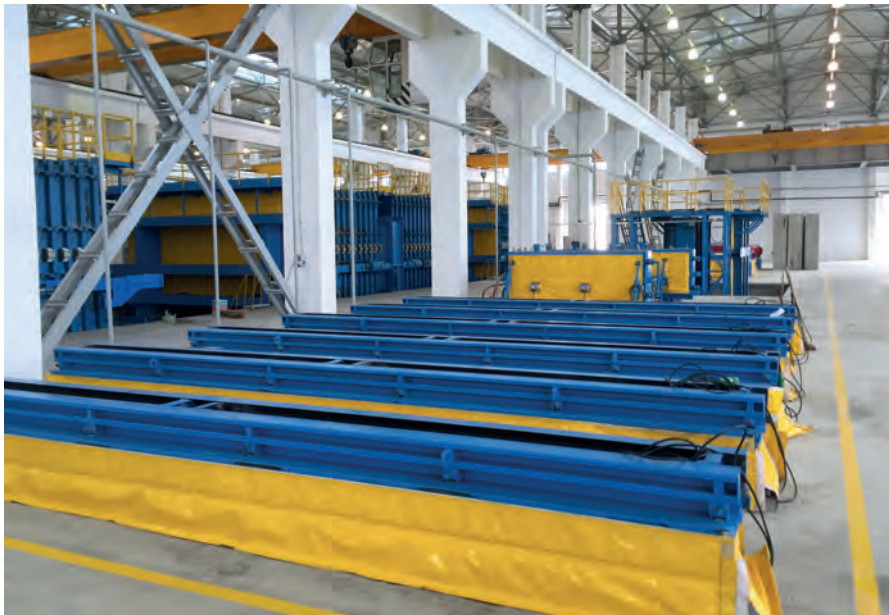
Con stampi aggiuntivi, un totale di 15 per la precisione, si possono produrre, tra l'altro, travi (primo piano), scale (al centro della foto) e pozzi di ventilazione (sullo sfondo). Un sistema di riscaldamento integrato accelera la maturazione del calcestruzzo.
