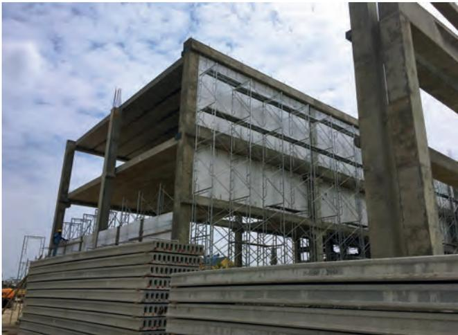
*Avec les installations et les systèmes de coffrage fournis par Echo Precast Engineering et Tecnocom, Boleyn Magic Wall fabrique des dalles en béton précontraint, des murs sandwich, des colonnes, des poutres ainsi que d'autres éléments préfabriqués en béton structurels et spéciaux.*
