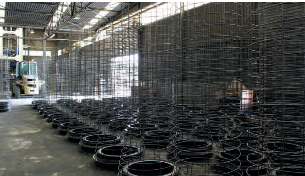
Arandelas base preparadas con la armadura
