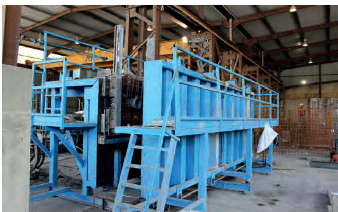
Encofrado para la fabricación de muros de contención
