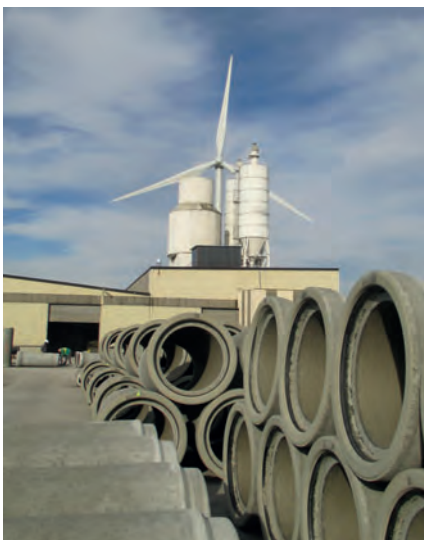
Una de las dos turbinas eólicas de 2 MW de Tubobel
