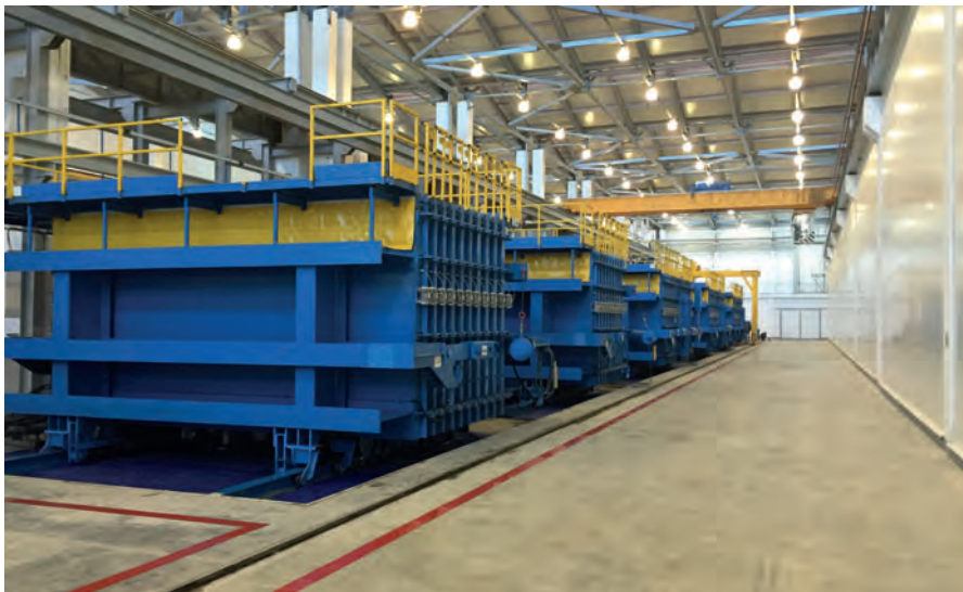
Con un total de 18 encofrados en batería, en una superficie reducida se fabrican losas y muros macizos.
