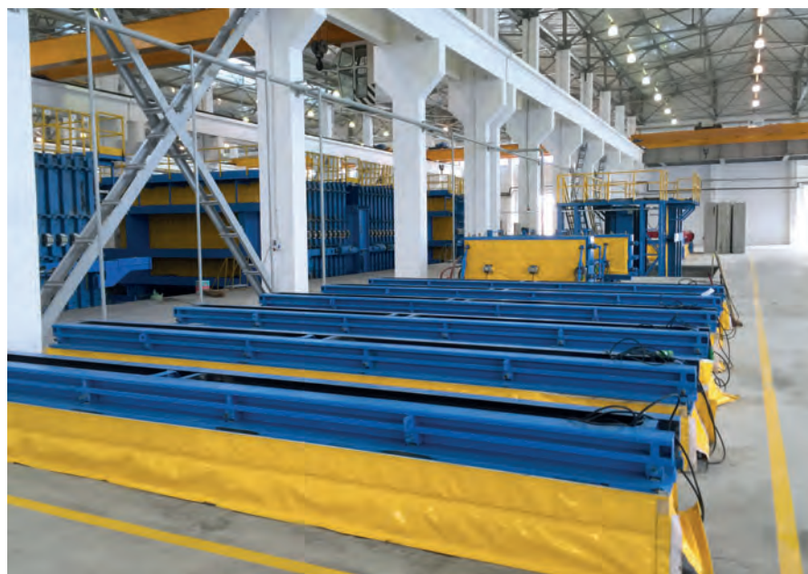
Mit zusätzlichen Formen, insgesamt 15 an der Zahl, können u. a. Riegel (Vordergrund), Treppen (Bildmitte) und Belüftungsschächte (Hintergrund) produziert werden. Ein integriertes Heizsystem beschleunigt die Aushärtung des Betons.
