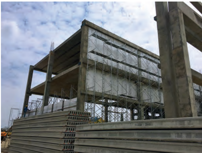
Mit den Anlagen und Schalungssystemen von Echo Precast Engineering und Tecnocom stellt Boleyn Magic Wall Spannbetondecken, Sandwichwände, Stützen, Träger sowie weitere konstruktive Betonfertigteile und Sonderelemente her.
