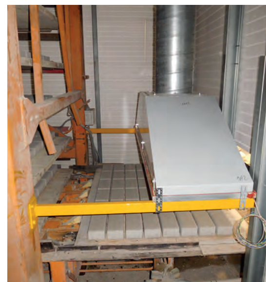
Один из двух обогреваемых колпаков, установленных между опускным штабелером и стенкой камеры для предотвращения выхода теплого и влажного воздуха и попадания капель конденсата на свежесобетонированные изделия
