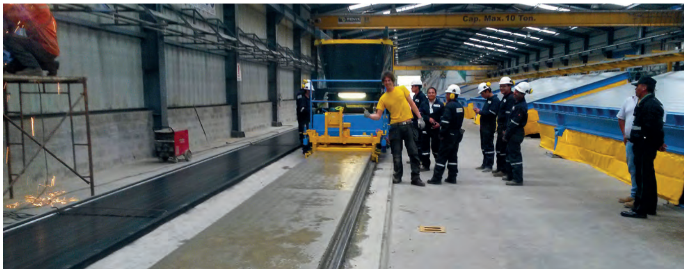
Преднапряженные ж/б перекрытия изготавливаются на двух дорожках длиной 114 м при помощи слипформера фирмы Echo Precast Engineering
