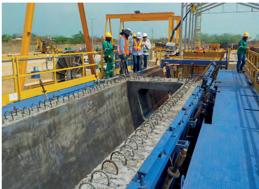
Системы вибрации и отопления служат для равномерного уплотнения и твердения уложенной бетонной смеси. Для моста «viaducto Gran Manglar», самого длинного автодорожного моста в Колумбии, изготавливаются V-образные балки различной длины и весом до 85 тонн
