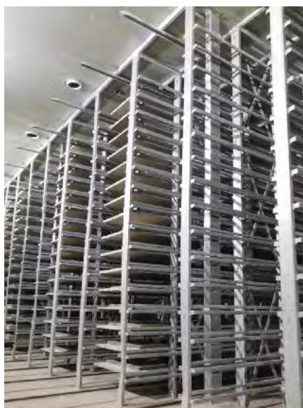
Przewody rozprowadzające powietrze wewnątrz komory, służące także do ograniczania prędkości powietrza do wartości poniżej 1,00 m/s.
