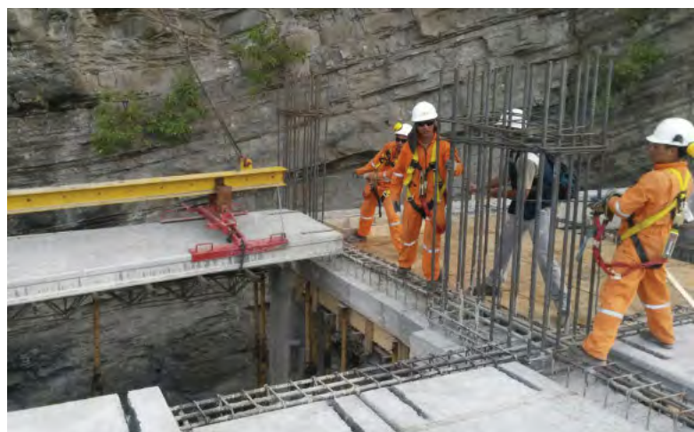
EPCE dostarczyła do Riobamba, największego miasta w Ekwadorze, sprężone płyty stropowe o długości 8 m o łącznej powierzchni 10 tys. m 2 .
