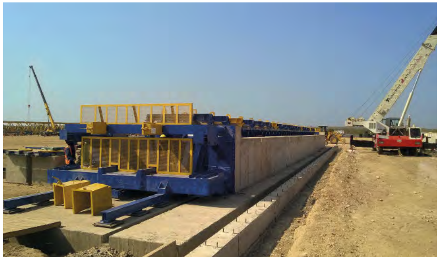
Szalunek o długości 40 m został zamontowany niedaleko placu budowy. Może on być stosowany niezależnie od miejsca, ponieważ posiada konstrukcję umożliwiającą
