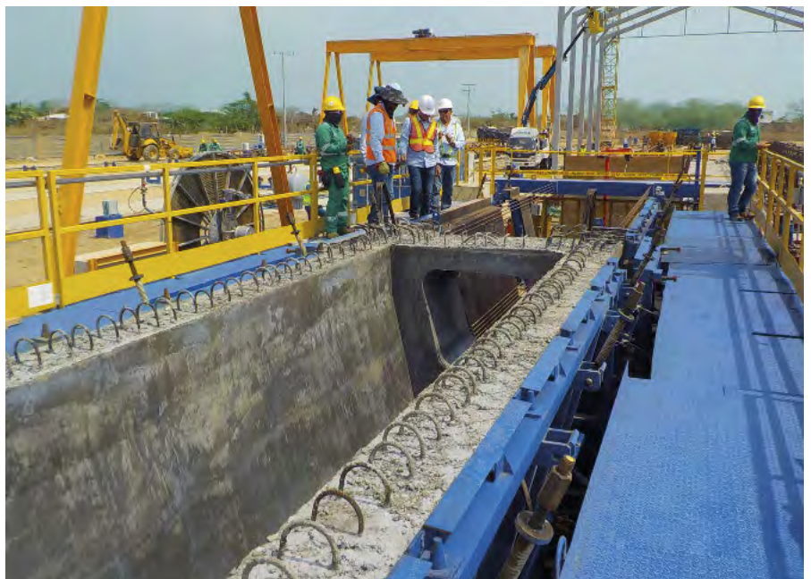
System wibrowania i przyspieszonego dojrzewania betonu zapewnia jednorodne zagęszczanie i przyspieszone twardnienie ułożonej mieszanki betonowej. Dla „viaducto Gran Manglar”, najdłuższego mostu drogowego Kolumbii, produkowane są dźwigary w kształcie litery V o trzech różnych długościach i masie do 85 ton.
