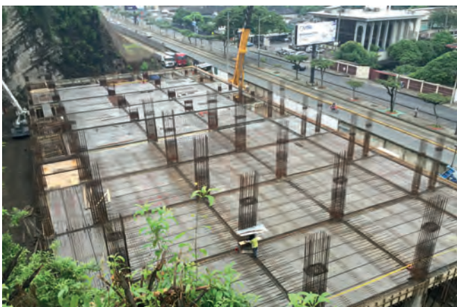
En août de cette année, un parking à étages multiples de cinq étages a été achevé pour l'université catholique de Guayaquil. Il est d'ores et déjà prévu de rehausser l'ouvrage de deux étages.
