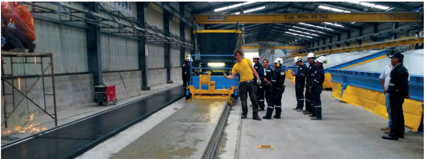
Les dalles en béton précontraint sont produites sur deux lignes de 114 m de long à l'aide d'une fileuse d'Echo Precast Engineering
