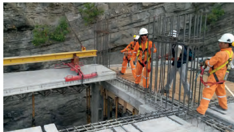
EPCE a fourni des dalles en béton précontraint de 8 m de long chacune pour une surface totale de 10 000 m 2 depuis Riobamba, la plus grande ville d'Équateur.
