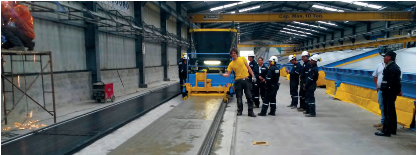
Las placas alveolares se fabrican en pistas de 114 m de longitud con ayuda de una máquina deslizante de Echo Precast Engineering.
