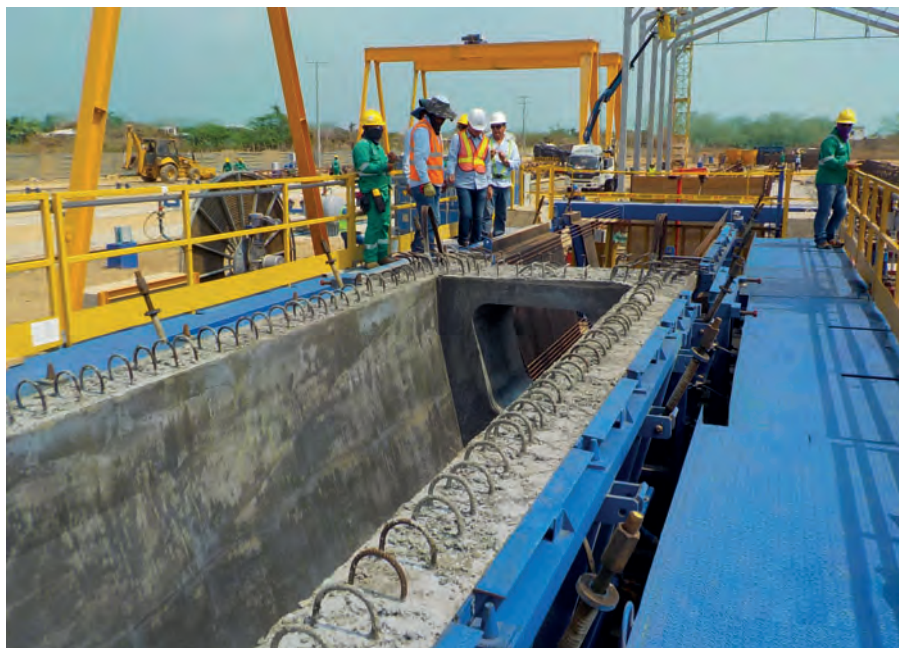
Un sistema de vibración y otro de calefacción proporcionan una compactación y un curado uniforme del hormigón. Para el "viaducto Gran Manglar", el puente de carretera más largo de Colombia, se fabrican vigas en V con tres longitudes diferentes y con un peso de hasta 85 toneladas
