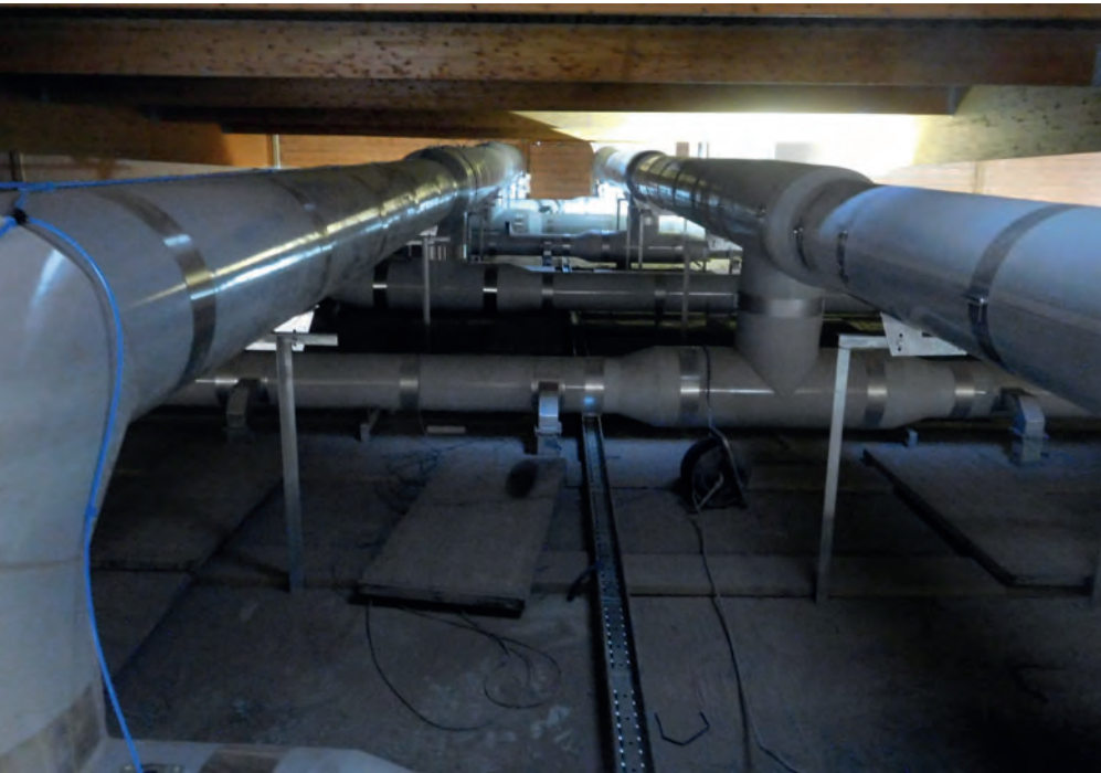
Die isolierte Luftkanalverrohrung oberhalb der Kammer mit Hochleistungsbefeuchtungsdüsen.
