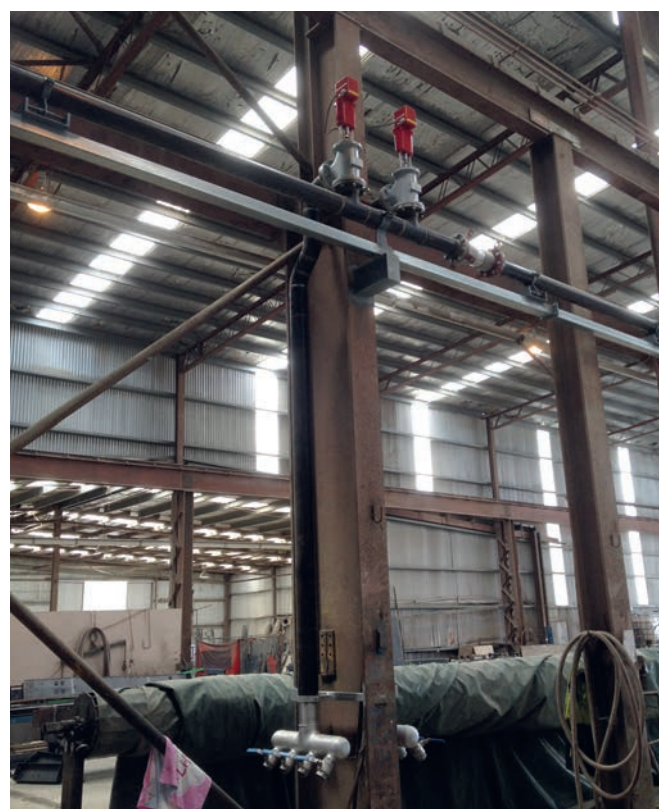
Рис. 4: Паровые клапаны с автоматическим управлением регулируют объем пара для каждой зоны выдержки и желаемую температуру бетона для соответствующего цикла выдержки
