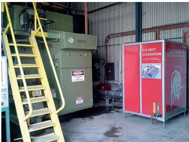
Fig. 3 : Le générateur de vapeur Kraft compact Curing KC 20 – 1S (à droite) remplace aujourd'hui l'ancienne chaudière. Pour un rendement comparable, les générateurs de vapeur Kraft prennent bien moins de place que les chaudières conventionnelles.
