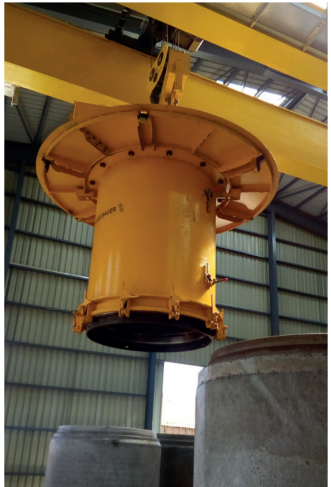
Le tuyau qui a été fraîchement réalisé est amené vers la zone de durcissement en utilisant un pont roulant.
