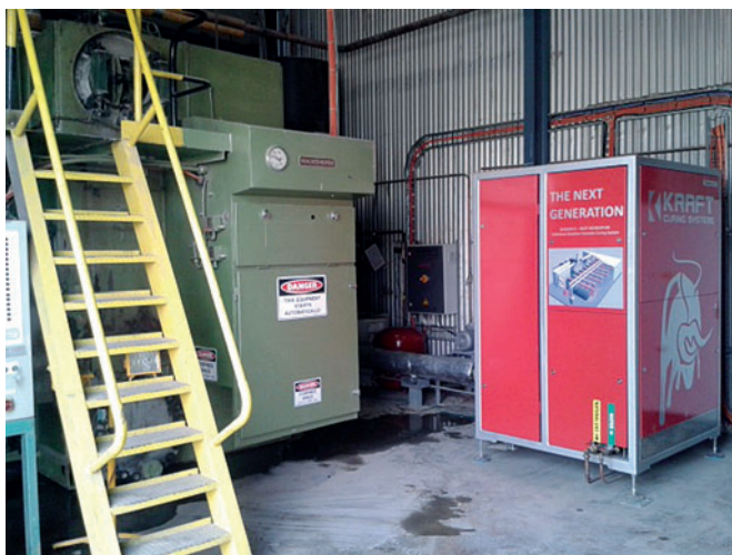
Fig. 3: El compacto generador de vapor KC 20 – 1S de Kraft Curing (derecha) sustituye ahora a la caldera. Los generadores de vapor de Kraft ocupan mucho menos espacio que una caldera de vapor convencional con el mismo rendimiento
