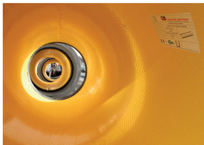
Футеровка из коррозионностойкого полиэтилена высокой плотности отличается надежностью и стойкостью к воздействию агрессивной химической среды
