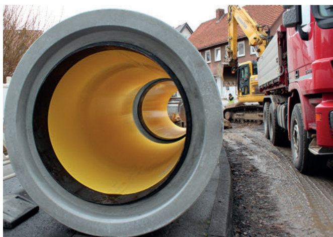
Промежуточный склад железобетонных труб DN1000 Perfect Pipe с интегрированным штекерным соединителем на строительной площадке в Зандерхаузене, коммуна Нистеталь
