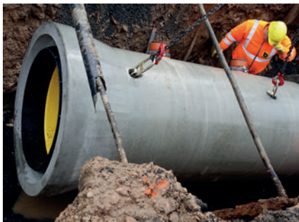
Осторожное опускание трубы и стыковка с уложенным участком канализационной сети
