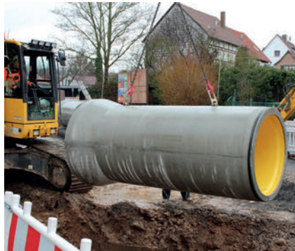
Укладка трубы в траншею при помощи цепных строп
