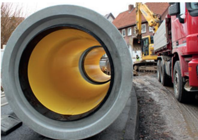
Stoccaggio provvisorio di tubi in cemento armato Perfect Pipe DN1000 Perfect Pipe con elementi di collegamento in plastica applicati in fabbrica nel cantiere di Sandershausen, comune di Niestal.
