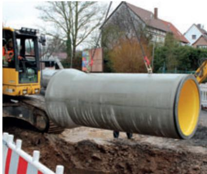
*Inserimento nello scavo con l'aiuto di un tirante a catena fissato a due ancoraggi a testa sferica.*
