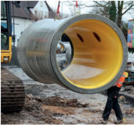
*Sollevamento di un tubo Perfect Pipe pronto per l'installazione con due aperture di afflusso.*
