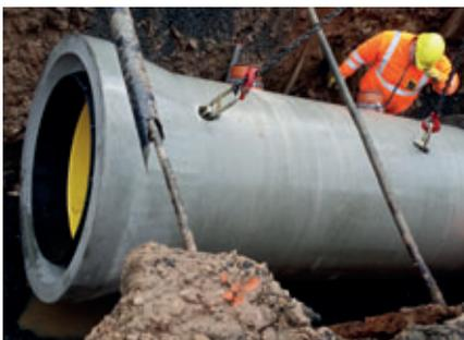
*Posa del tubo e collegamento alla nuova canalizzazione.*
