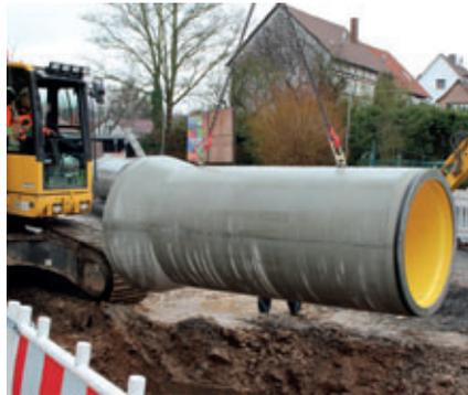
Mise en place dans la tranchée à l'aide d'une élingue chaîne fixée sur deux ancrs à têtes sphériques.
