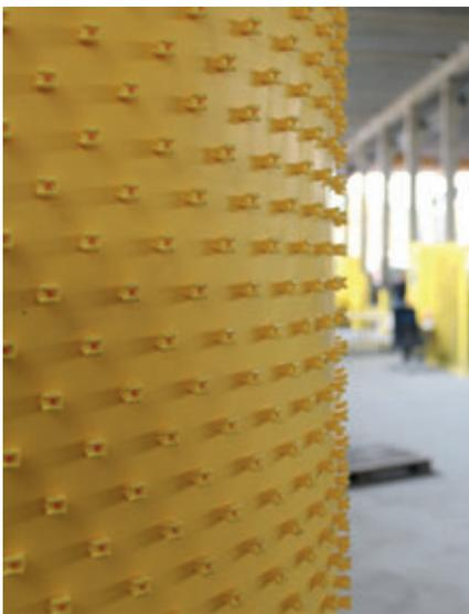
La liaison solide qui se crée entre le revêtement et le tuyau en béton tient à une multitude de petits ancrages sur l'envers du film PEHD.
