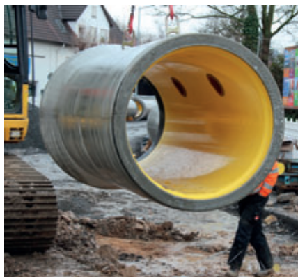
Anheben eines einbaufertigen Perfect Pipe Rohres mit zwei seitlichen Zulauföffnungen
