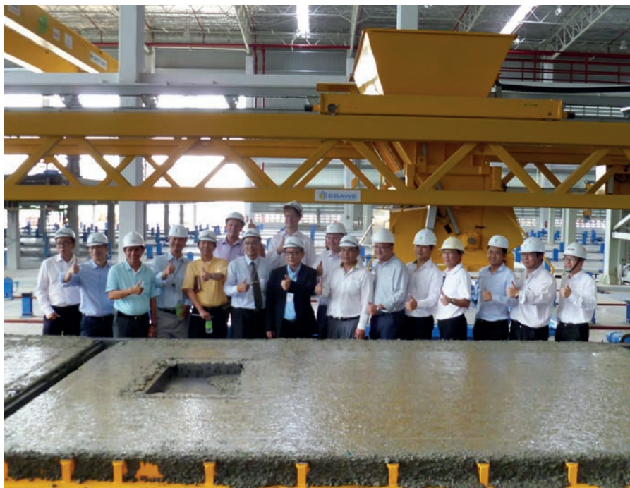
Успешное бетонирование первых элементов! Сотрудники компаний Pruksa и Progress Group приложили все усилия для реализации проекта в требуемые сроки
